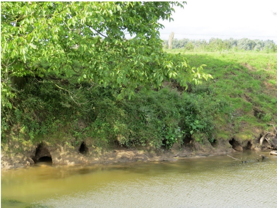
Foto des Zeugen „Heinz-Günther Stallmeyer“. Höhlengänge im Uferbereich
